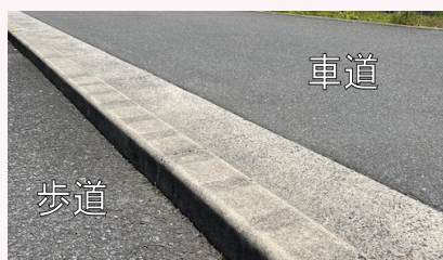
歩行者に優しい市役所の歩道 (歩道と車道の高さが、ほぼ同じ)
